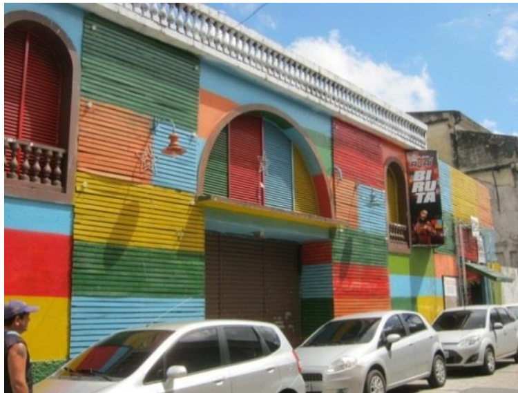
Figura. 09 – Sobrado adaptado a uma casa noturna, localizado na Rua Siqueira Mendes. Fonte: Arquivo Pessoal, mar.2014.
